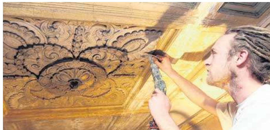
Stuckateur Thomas Bauch restauriert die Decke eines Durchgangs. Fotos: André Kempner
