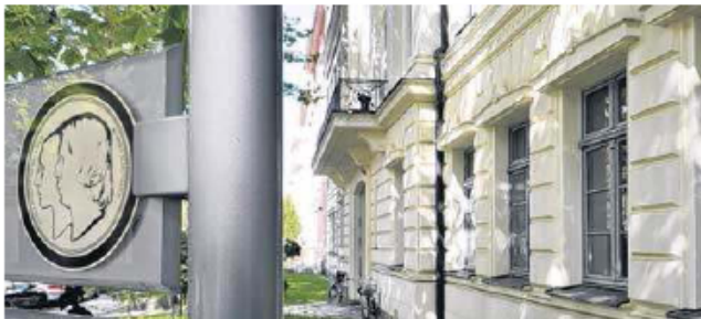
Das klassizistische Gebäude ist saniert – beherbergt heute die Freie Grundschule „Clara Schumann“, ein Museum und einen kleinen Konzertsaal.
